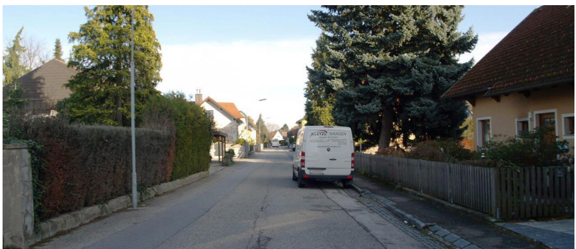
Abbildung 9: Rüdigerstraße Blick aus der Nibelungenstraße Richtung Osten - Quelle: Büro DI Liske
